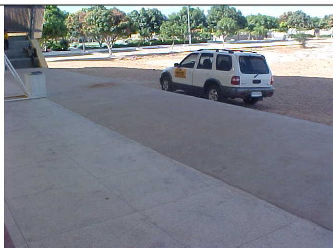
**Foto 02 – Vista geral do piso da quadra, mostrando o ponto até onde foi executado o piso em granilite e a partir de onde foi executado piso cimentado áspero, onde deveria ser granilite.**
