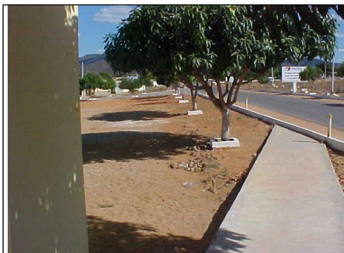
**Foto 01 – Vista do local onde deveria ter sido instalada a grama em placas, mostrando que a mesma não foi executada.**
