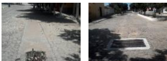
Fig.11 – Sistema de galeria, bocas de lobo, sarjetas.
