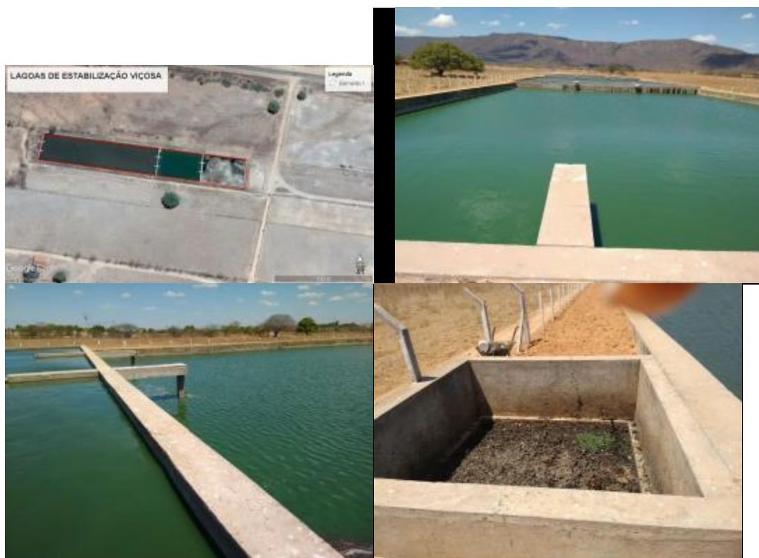
Fig.25,26,27,28 – Lagoas de estabilização de Viçosa. Imagem de satélite – Google Earth Pro –Acesso em 12/12/2017. Fotos in loco.
