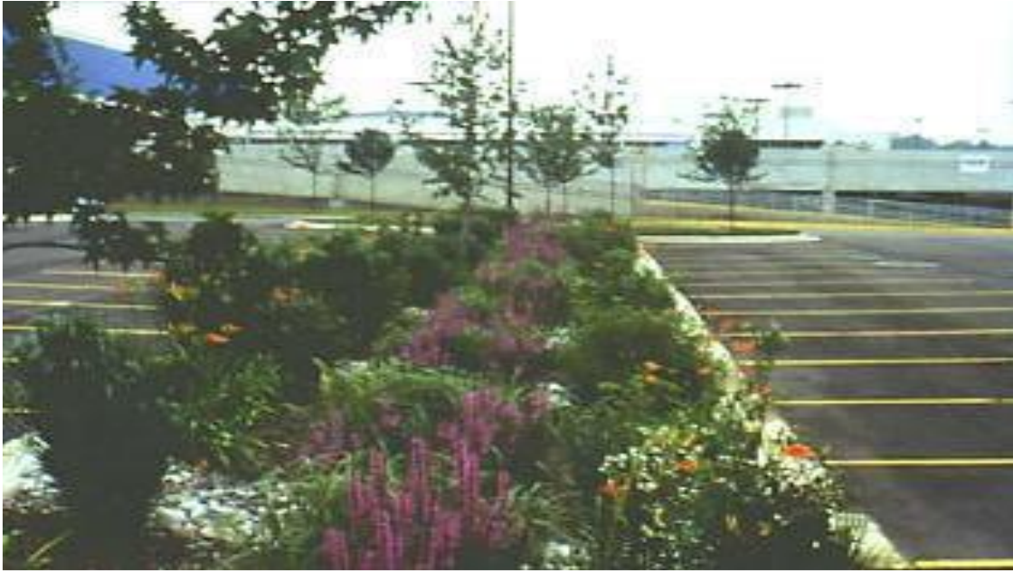
Figura 17 - Exemplo de uma célula de biorretenção colocada em um estacionamento: Dimensões: 11,6 m x 3,6 m, profundidade = 1,2 m. Um dreno subterrâneo no fundo para drenar e evitar saturação, o qual foi coberto por 20 cm de pedregulho (2,5 a 5 cm), preenchido com mistura do solo a uma profundidade de 30 cm abaixo do meio fio.
